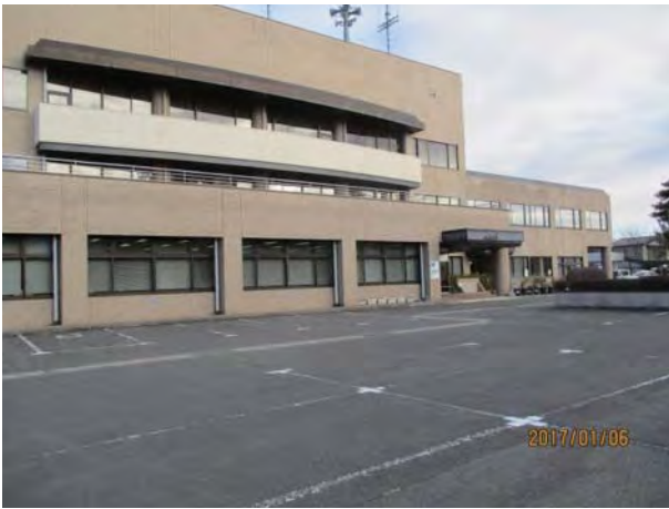
福島市役所飯野支所
