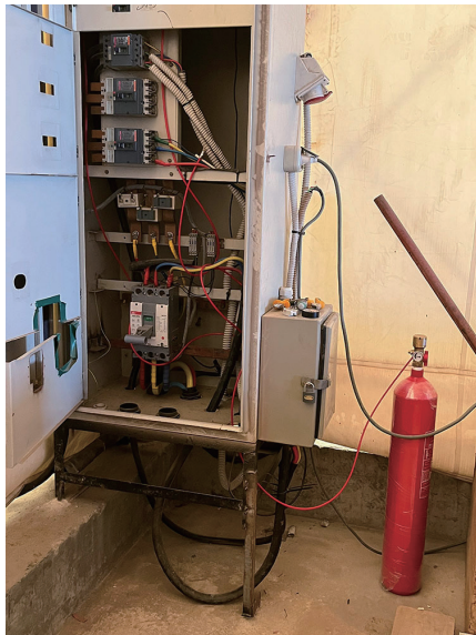
図 12 配電盤に取り付けた消火システム
