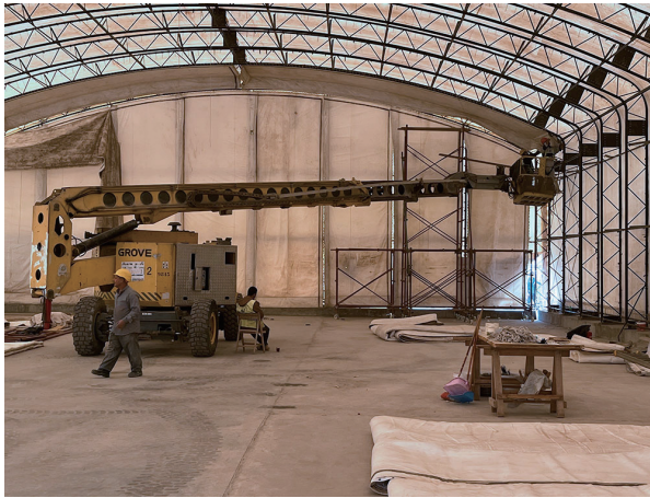
高所作業車による内膜張り
