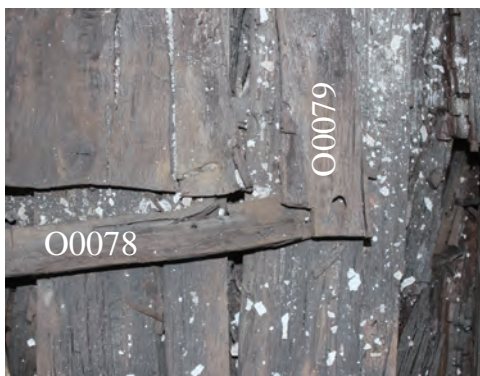
Fig. 6 梁・桁のおさまり詳細
