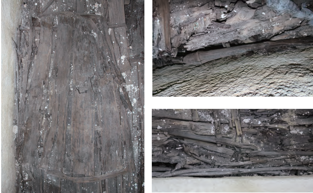
Fig. 2 船首楼部材の検出状況
