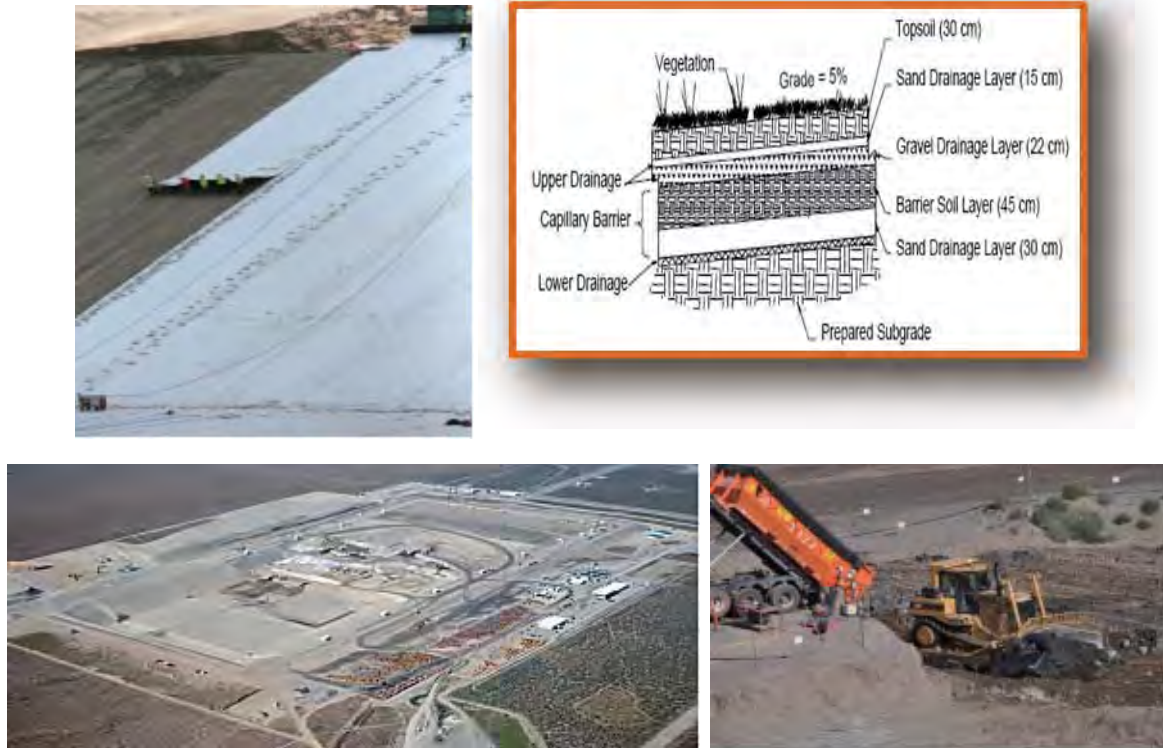
図 25. 低レベル放射性および有害廃棄物処分用の環境修復処分施設、ERDF
