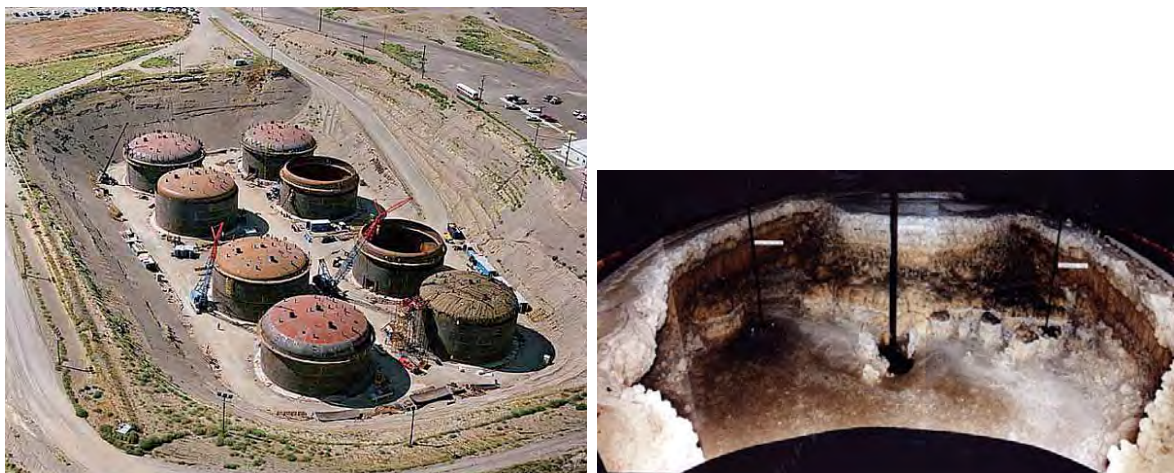
図 4. 177 の地下貯蔵タンクの一部（右図）と放射性タンク廃棄物の地殻（左図）
